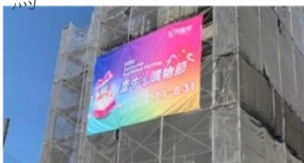
都發局 / 建設局 - 工程外牆大型輸出
